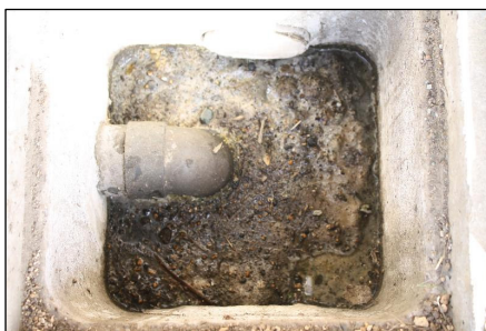
改修工事前(固形物堆積)
